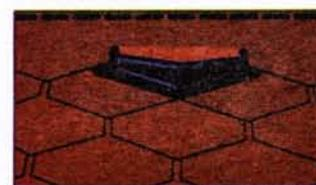
Acoperișurile calde trebuie tot timpul să fie aerisite cu spații. Conducerea aerului se realizează sub igheabul de acoperiș, canal de aerisire prin ventilație. Noi livrăm și elemente de aerisire a acoperișului din plastic, care corespund dimensiunilor și formelor dvs. de șindrilă. Suprafața de aerisire a unei unități de ventilație este de cca. 75cm<sup>2</sup>.
